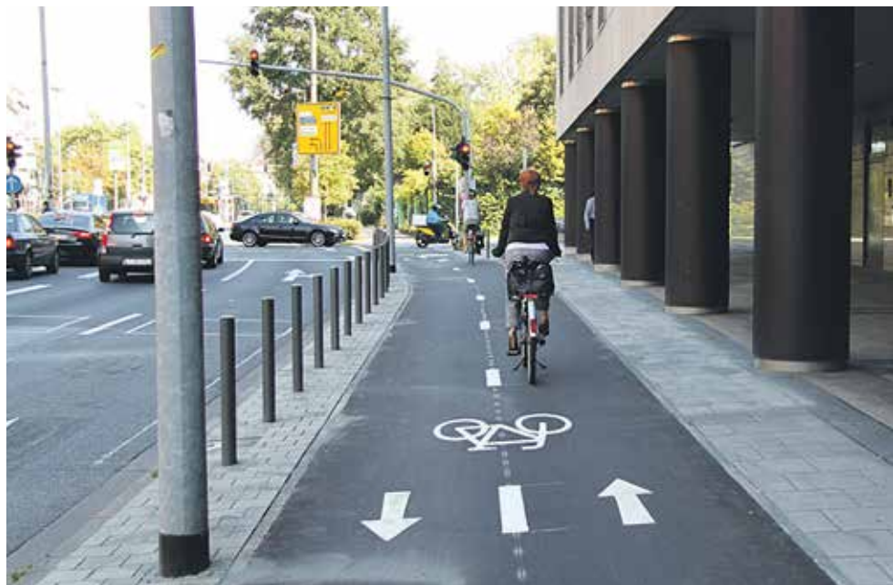
Frankfurt: Radweg, der in zwei Richtungen zu befahren ist (Konrad-Adenauer-Straße). Foto: Torsten Willner, ADFC.
